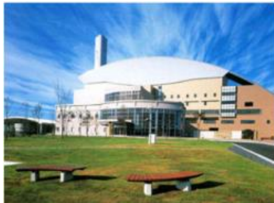
クリーンパーク茂原(ごみ焼却施設)
