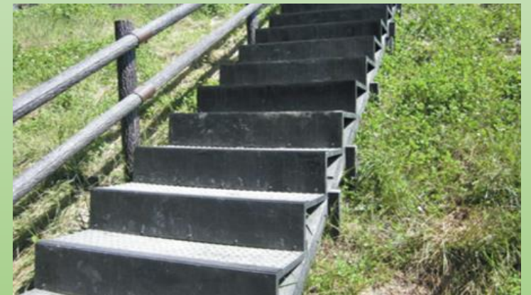
のり面点検用階段
