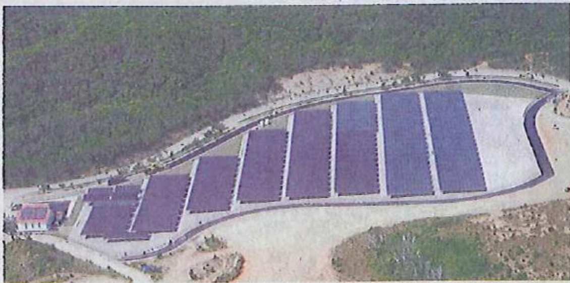
沖縄電力が運転を開始した本島初の大規模太陽光発電設備「安部メガソーラー実証研究設備」＝名護市安部（同社提供）
